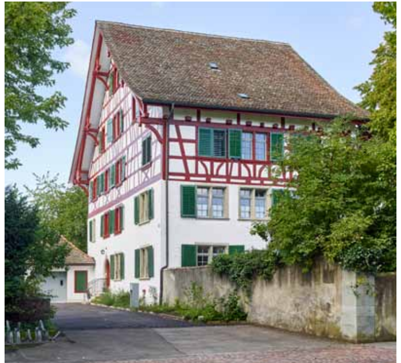
Das Pfarrhaus erstrahlt in neuem Glanz. Foto: Jürg Zimmermann
